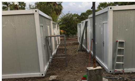
コンテナ製の教室がほぼ完成
