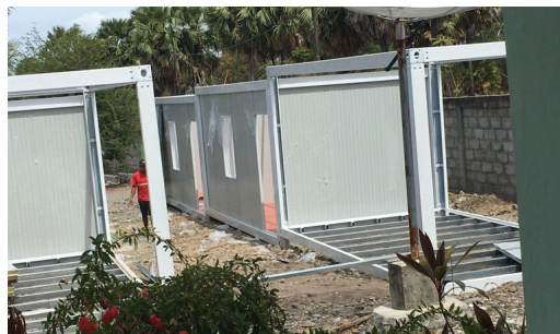
組み立て中のコンテナ製の教室
