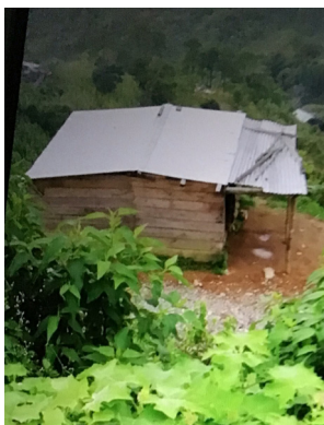
完成した屋根
