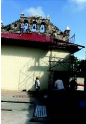
教会の修復作業
